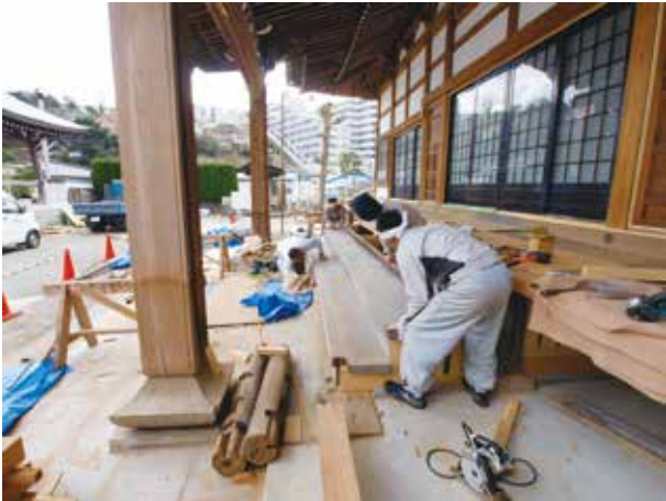
浜縁の階段の取り付け
