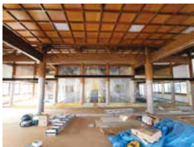
作業中の本堂の屋内
