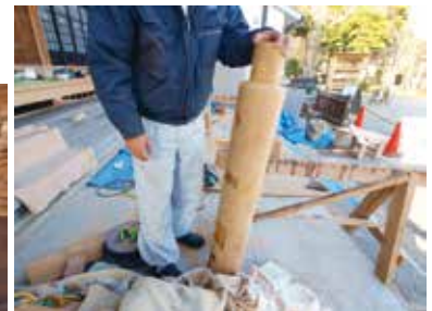
新しい手すり柱
