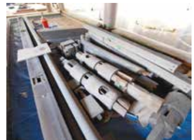
解体された浜縁の手すり
