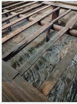
床を撤去した建屋。地震による液状化現象により地盤が歪んだ
