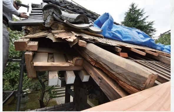
「部分的な補修」とはいえ、瓦の土台部分は新しい木で組み直し、屋根の側面の「破風板(はふいた)」も新しくなりました。瓦の下には接着に泥が使われます。
