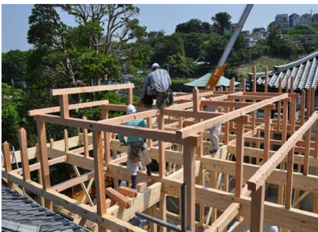
屋根工事中の渡り廊下
